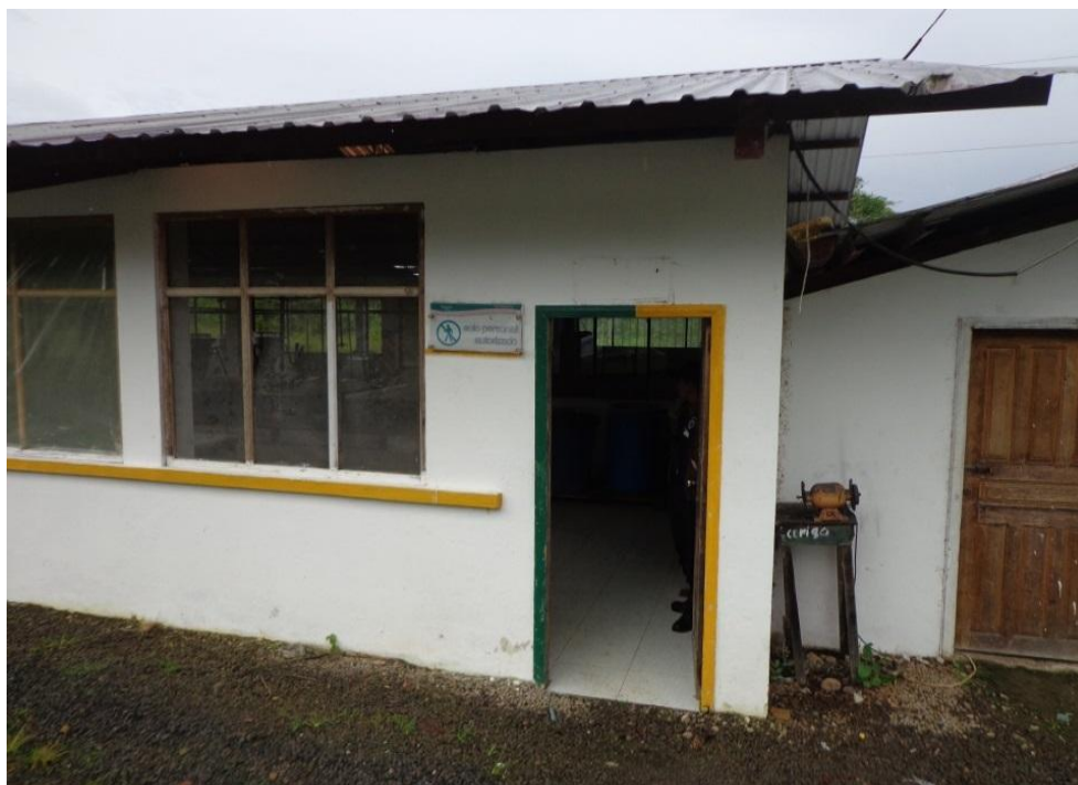
Fotografía 9. Uso indebido de la señalética.
