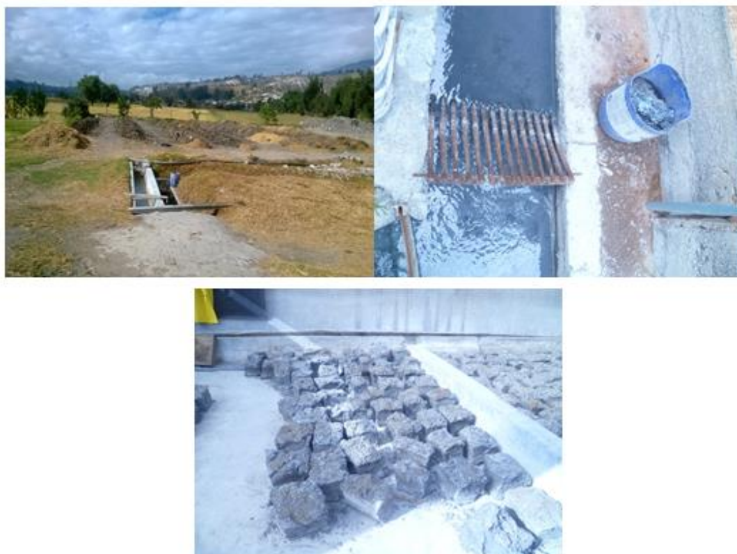
Fotografía 6. Disposición final del lodo residual proveniente de las descargas de agua.
