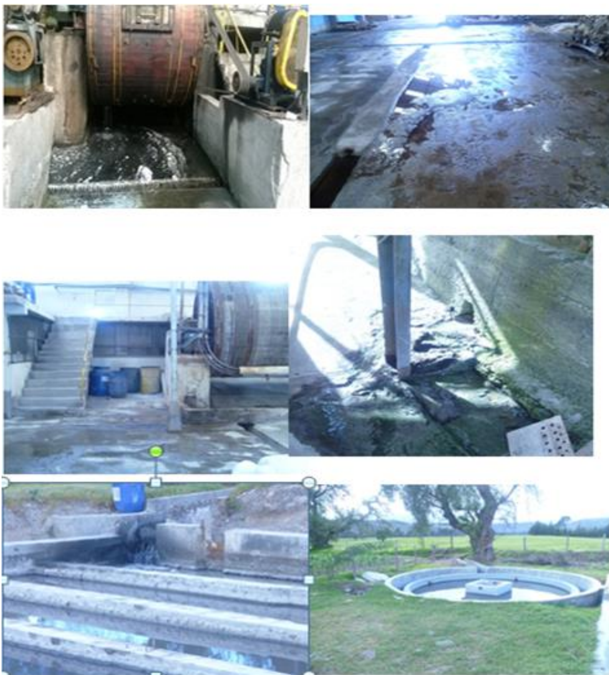
Fotografía 4. Drenaje y acumulación de las aguas residuales.
