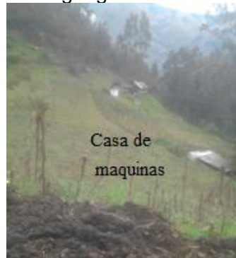
Figura 50. Ubicación geográfica de la casa de máquinas
