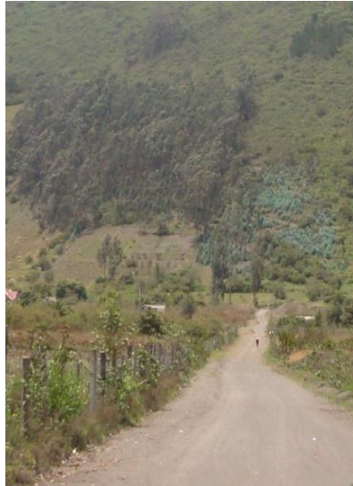
Figura 51. Vía de acceso a la casa de máquinas
