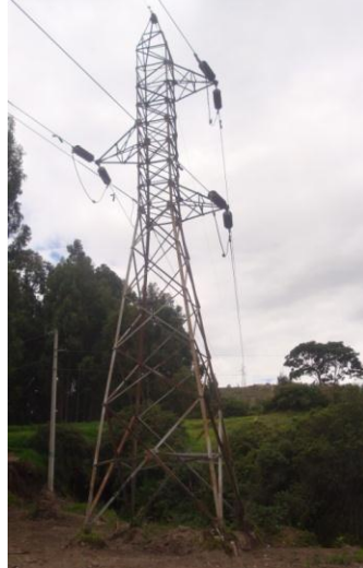
Figura 38. Estructura de ángulo
