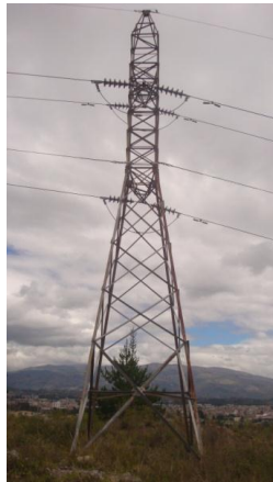
Figura 41. Estructuras metálicas de 18,5 m y de 69 kV
