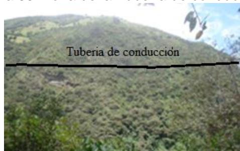
Figura 53. Zona de la Tubería de conducción
