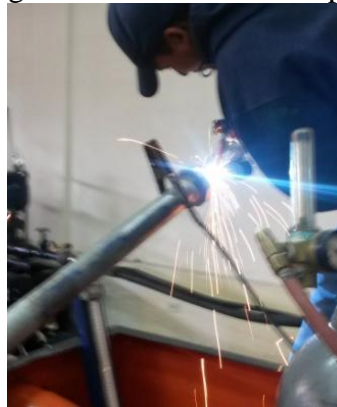
Figura 48. Soldadura de neplo
