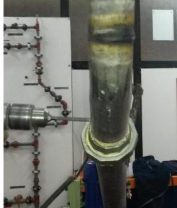
Figura 47. Perforaciones en la tubería
