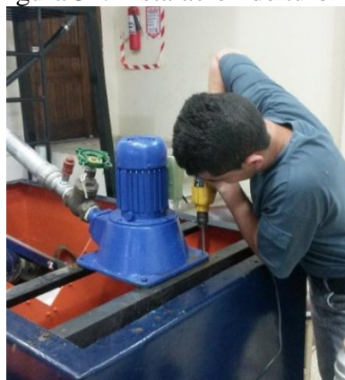
Figura 32. Instalación de turbina
