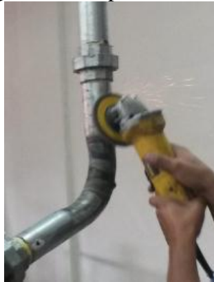
Figura 45. Limpieza de tubería
