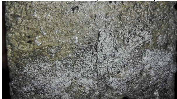
Figura 51. Grietas en la pieza proveniente de poliuretano.
