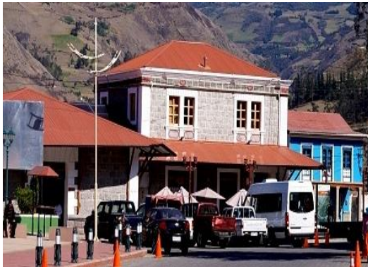
Foto No 20. Estación del Ferrocarril
