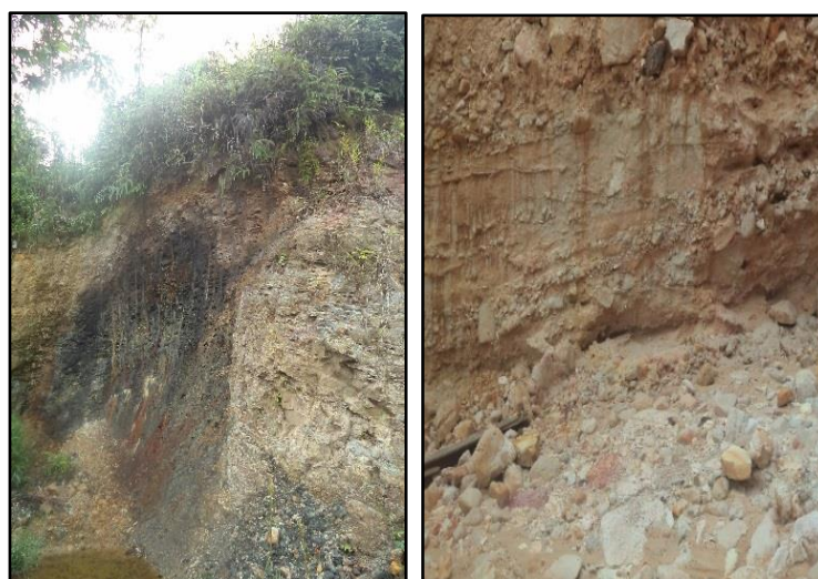
Fotografía 10: Pozos y trincheras exploratorios.
