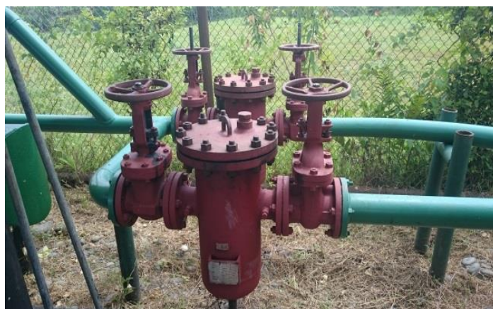
Figura 7-3. Filtros tipo strainer para el filtrado de agua.
