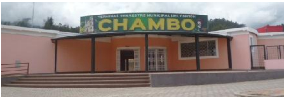
Figura N° 55: Unidad Técnica del Cantón Chambo
