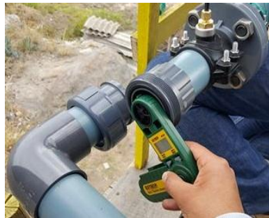
Figura 11. Medición de la velocidad de filtración.
