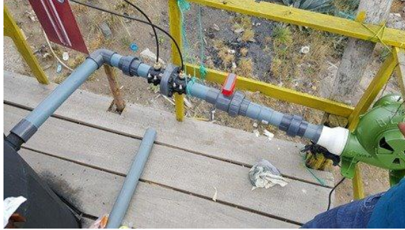
Figura 59. Instalación del medidor de caudal 1 PVC.
