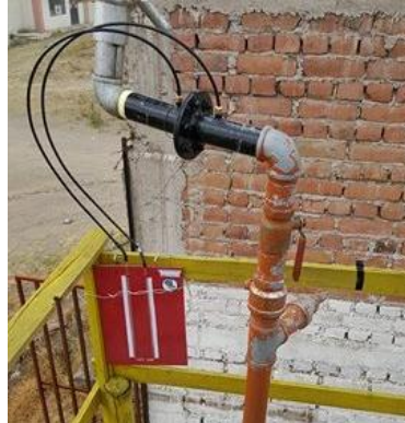
Figura 60. Instalación del medidor de caudal 2 acero.
