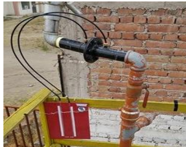
Figura 39. Ensamble medidor de caudal de acero – placa orificio
