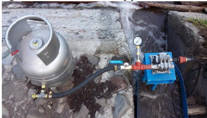
Figura 42. Medición de caudal y presión de la bomba
