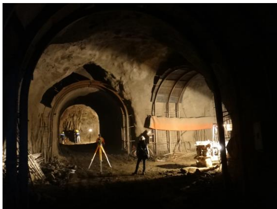
Fotografía 1. Intersección de Túneles: Venta N°4 y principal que conduce al pozo de presión
