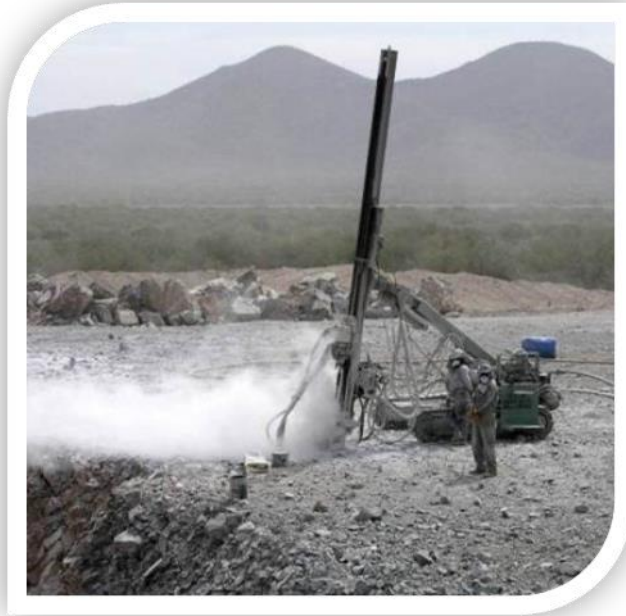
Fotografía 5: perforadora realizando barrenos en un banco de explotación.
