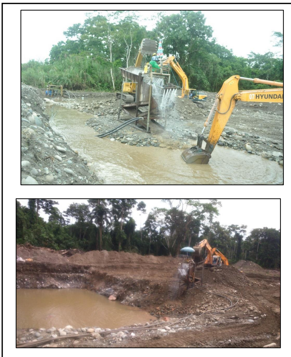
Fotografía 23. Desalojo de las colas del canalón (Descole)
