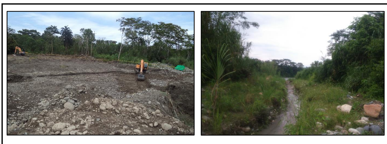
Fotografía 19. Cunetas de Coronación
