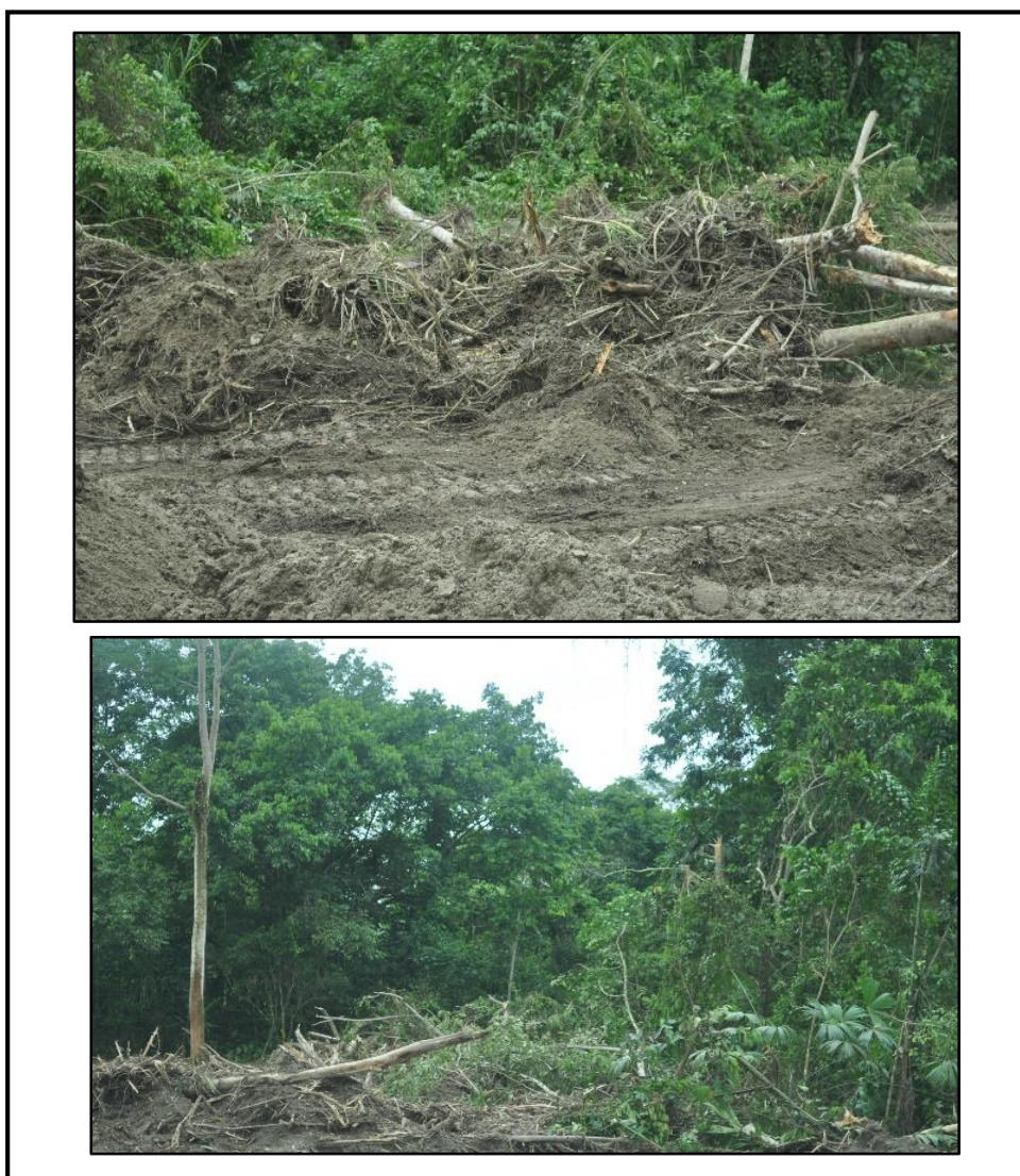
Fotografía 20. Retiro de la Cobertura Vegetal (Desbroce)
