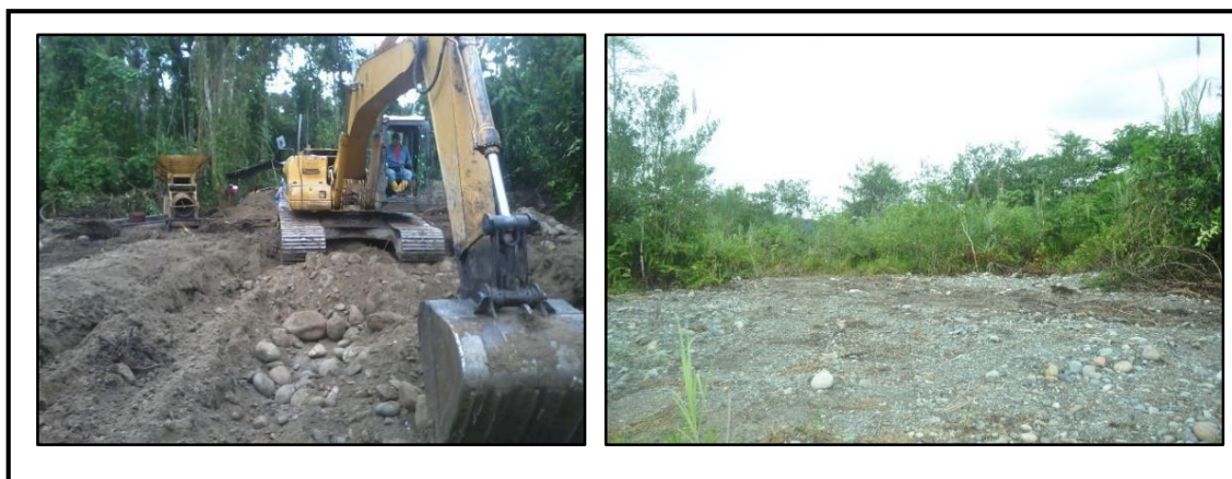
Fotografía 12. Área del pozo reconvertida
