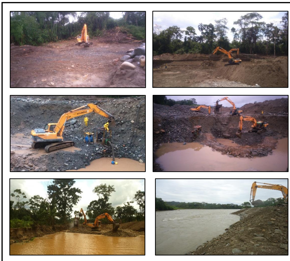
Fotografía 24. Labores efectuadas por la excavadora Hyundai 260LC-9S
