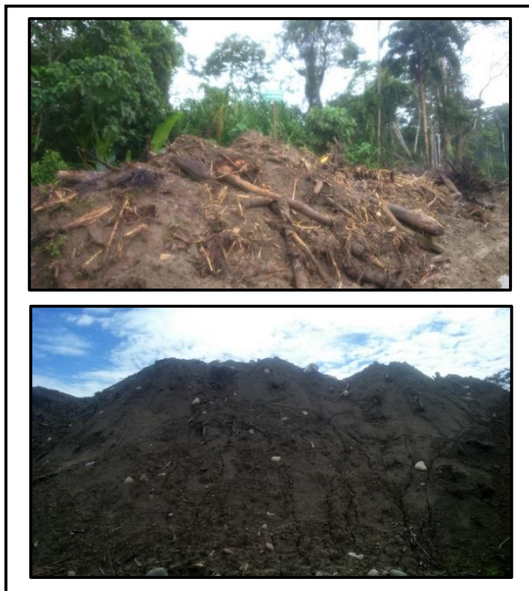
Fotografía 5. Cobertura vegetal y sobrecarga removida
