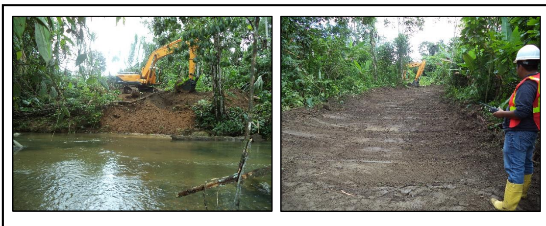
Fotografía 14. Construcción de la vía de acceso
