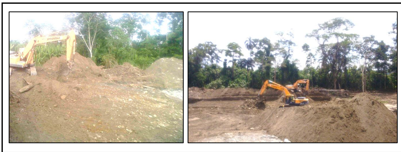
Fotografía 21. Retiro de la sobrecarga (Destape)
