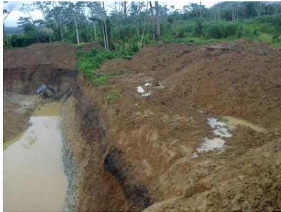
**Fotografía 24.**Talud del corte
