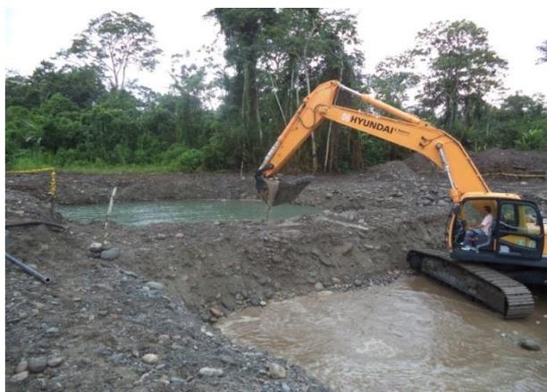
**Fotografía 25.** Conformación de Piscinas de Sedimentación y clarificación
