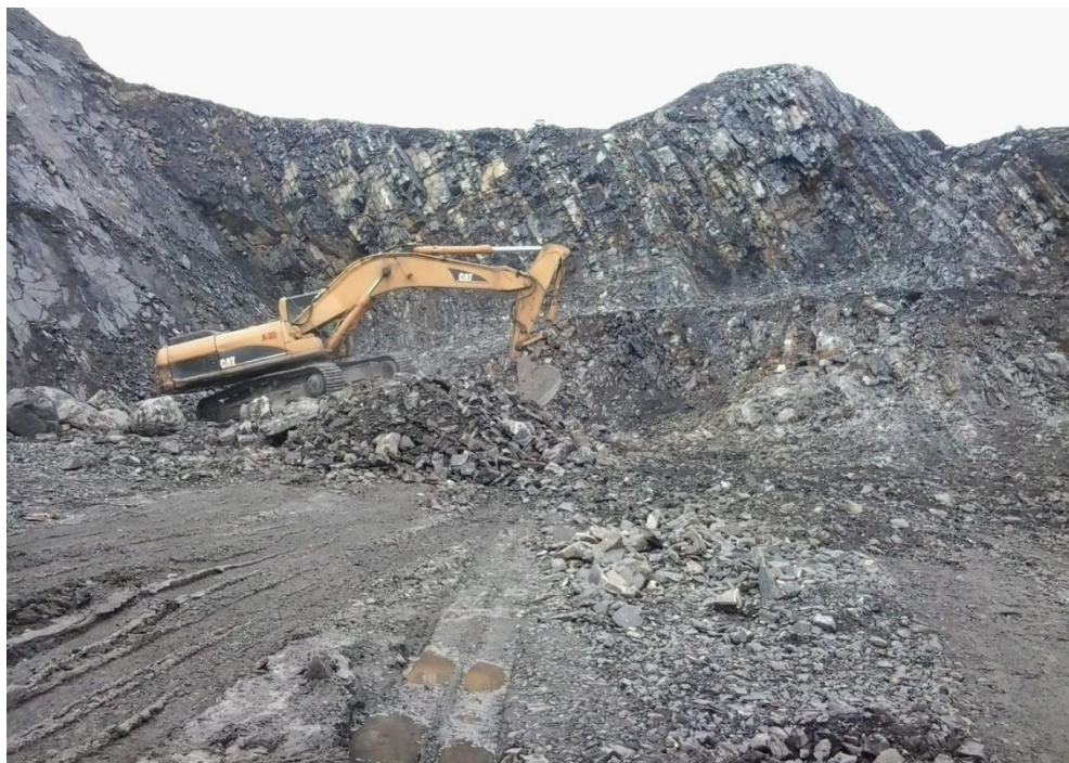
Foto 12: Ejecución de la rampa utilizada en la limpieza de la cobertura de la vía principal en la cota inferior al ingreso de la cota 735 msnm
