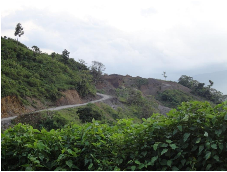
Foto 13: Vía de acceso a la cima del frente de explotación
