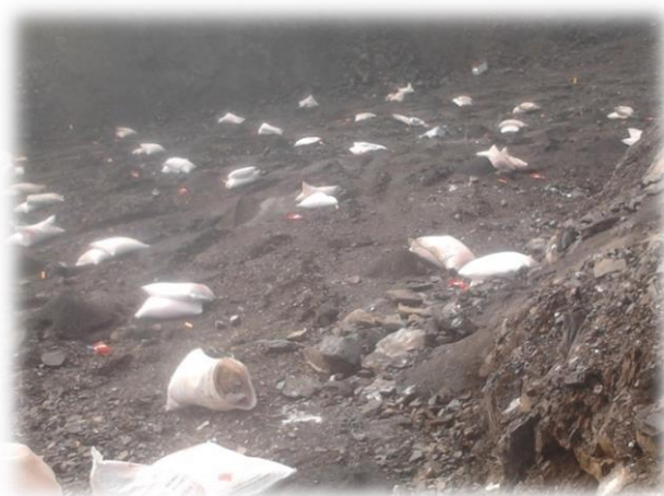
Foto 5: Anfo colocado en cada una de las perforaciones, utilizado como carga de columna.
