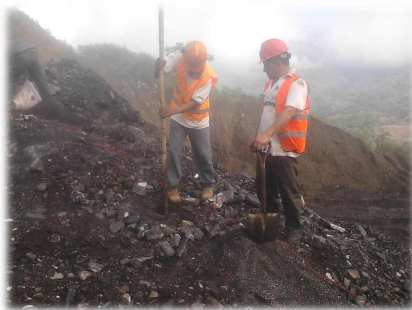
Foto 6: Retacando una de las perforaciones con material inerte para la voladura.
