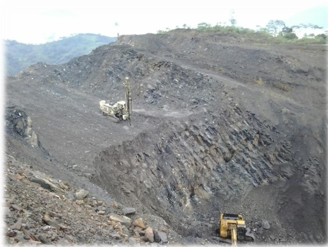
Foto 4: Perforadora Atlas Copco barrenando en Gretha Piedad en la cima.
