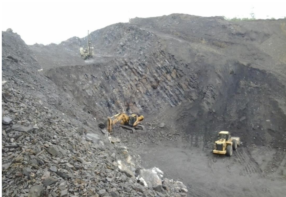
Foto 11: Abertura de la vía de ingreso y limpieza de la cobertura (material útil meteorizado y esteril )
