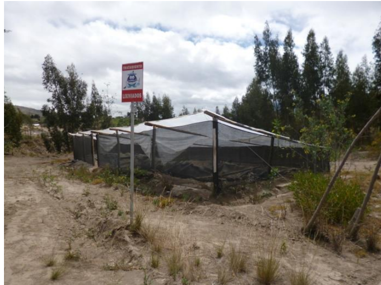
Figura 23-1. Entrada a la piscina de lixiviados Fuente: JÁCOME, David. 2015
