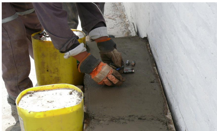
Figura 20-1. Encapsulamiento de pilas del relleno sanitario Fuente: JÁCOME, David. 2015
