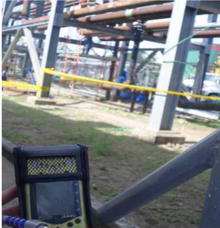
Fotografía N°7 Verificación continua con el explosímetro calibrado
