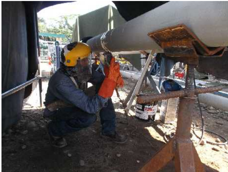
Fotografía N°38 Uso adecuado del Equipo de Protección Personal
