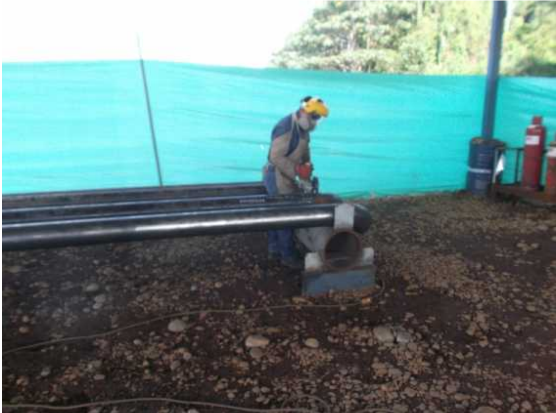
Fotografía N°3 Orden y Limpieza del Lugar.
