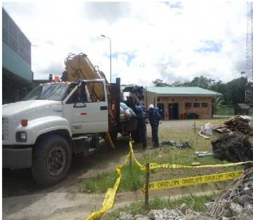
Fotografía N°20 Recolección de Residuos Sólidos
