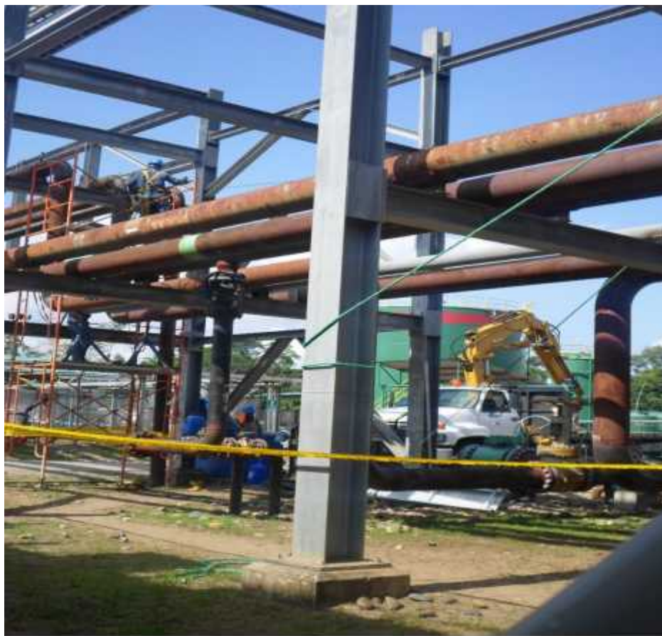
Fotografía N°6 Colocación de Tubería Con el camión Grúa
