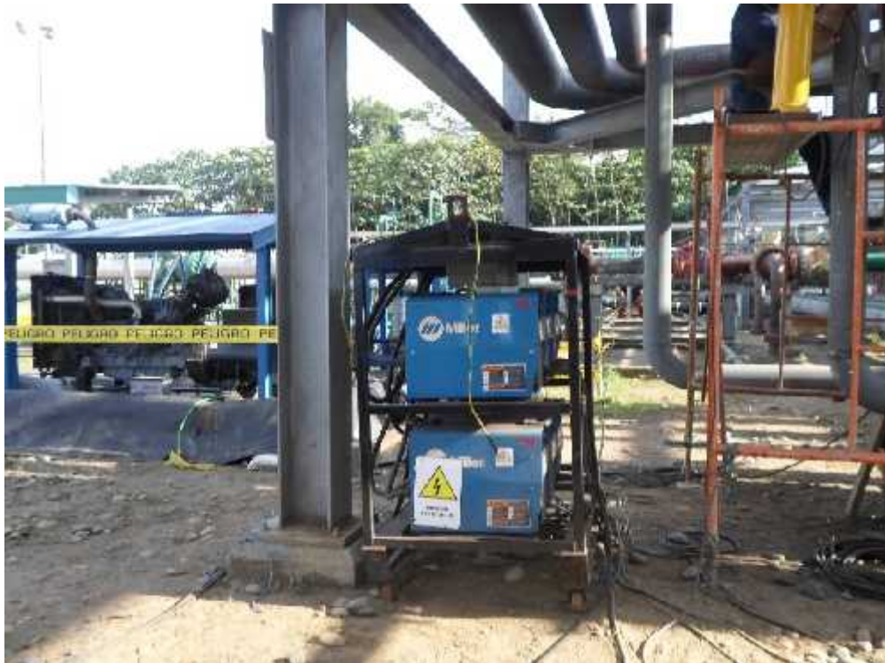
Fotografía N°14 Control Operacional y Señalización
