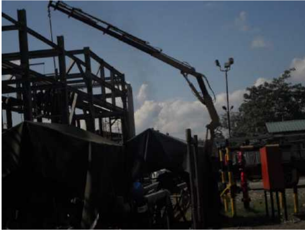
Fotografía N°5 Izaje de Tubería
