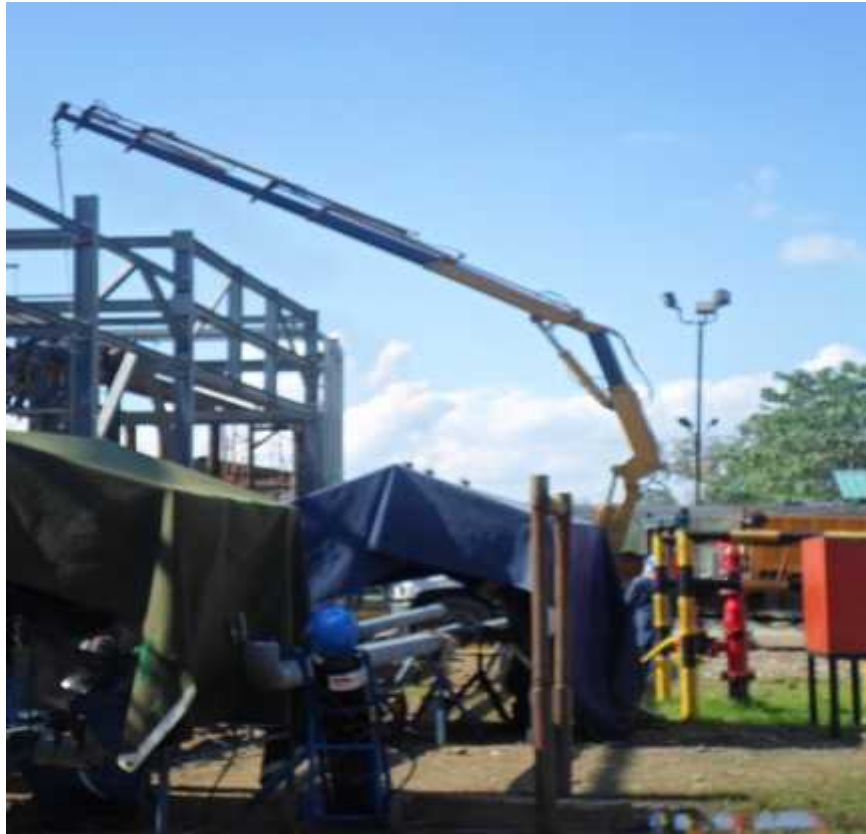
Fotografía N°8 Verificación del Plan de Izaje
