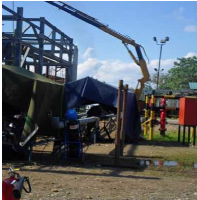
Fotografía N°4 Colocación de Señalética Necesaria
