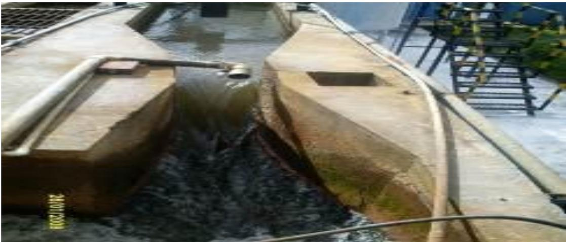
**Figura 4-1:** Medidor de parshall
