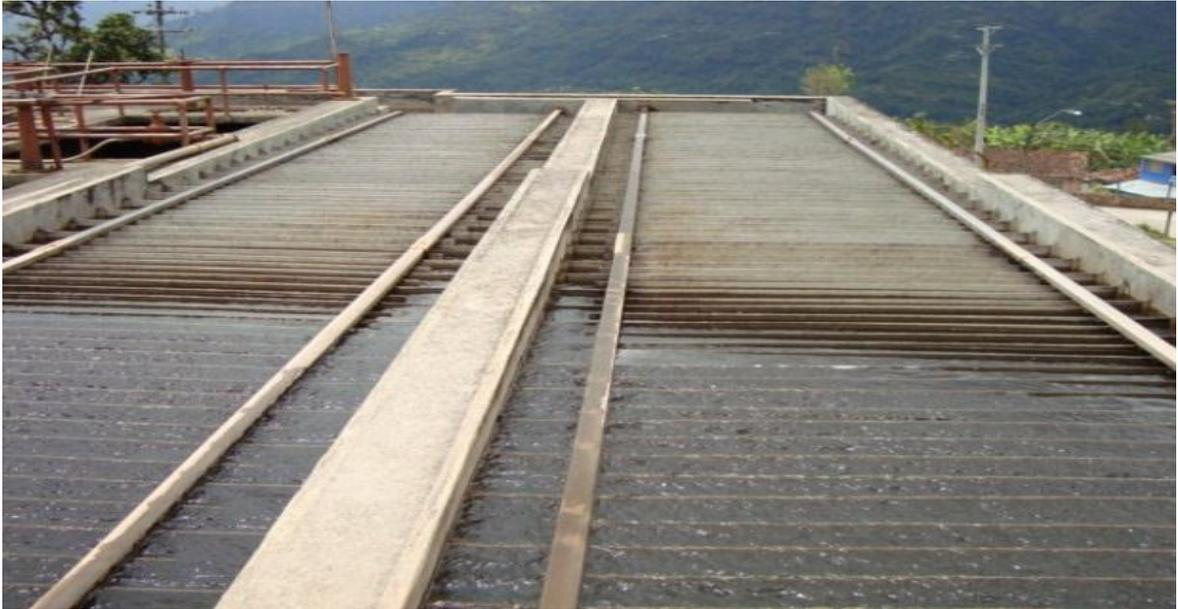
**Figura 7-1:** Sedimentador de alta tasa
