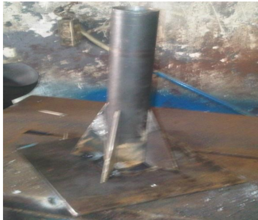
Figura 70. Montaje de las cartelas
