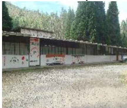
Figura 34. Instalacion de la planta de lácteos
