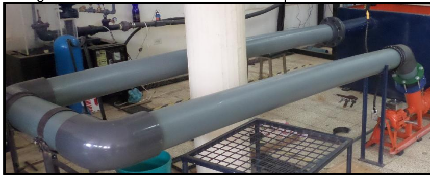
Figura 7. Tubería instalada con sus respectivos accesorios
