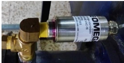
Figura 59. Instalación del sensor PX209-30V15G5V
