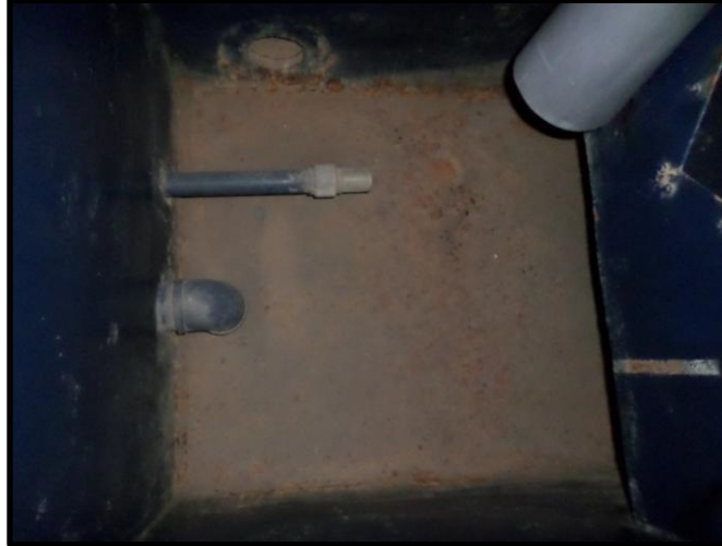
Figura 23. Estado anterior del tanque reservorio
