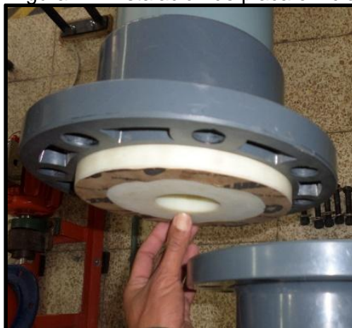
Figura 12. Instalación de placa orificio
