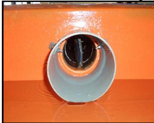
Figura 37. Acondicionamiento de la descarga al tanque
