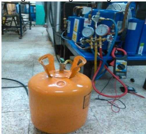
Figura 40. Carga de refrigerante
