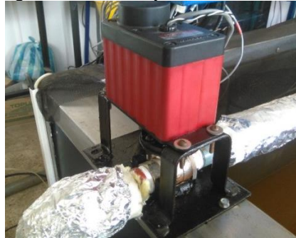
Figura 51. Montaje de servomotor
