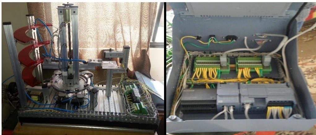
Figura 104. Revisión del cableado
