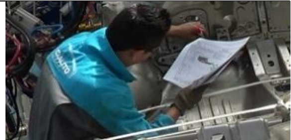
Figura 11-3: Marcado de los puntos de soldadura
