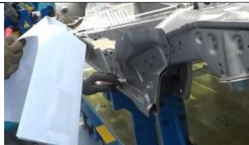
Figura 15-3: Verificación de los puntos de soldadura
