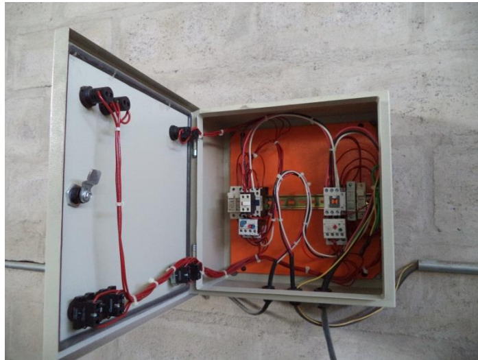
Circuito de mando y potencia
