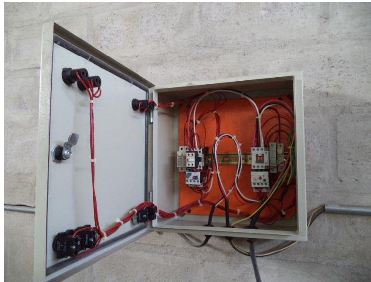
Circuito de mando y potencia
