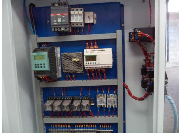
Circuito de mando y potencia
