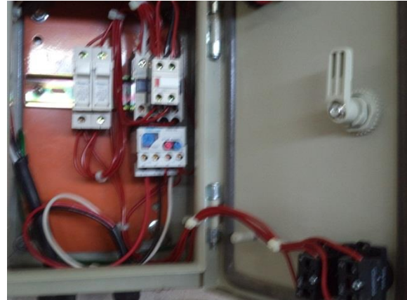
Circuito de mando y potencia
