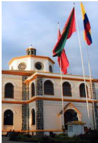
FIGURA 24-5: Fachada de la Politécnica
