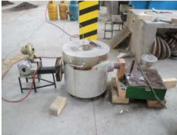
Figura 11. Sistema de fundición con Horno con quemador de GLP
