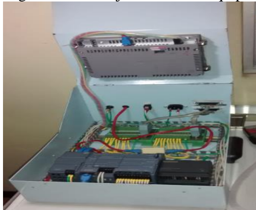
Figura 83. Montaje final de los equipos
