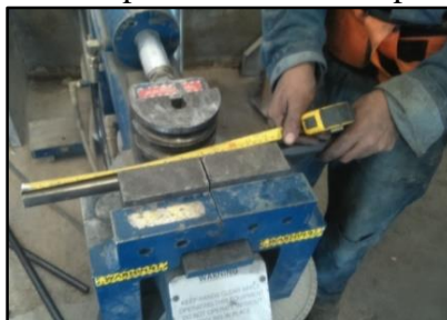
Figura 63. Comprobando medidas para doblar.
