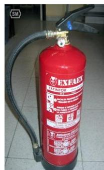
Figura 22 Modelos de extintores en polvo
