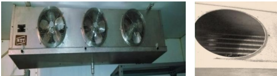
Figura 24. Evaporador de tubo aletado.
