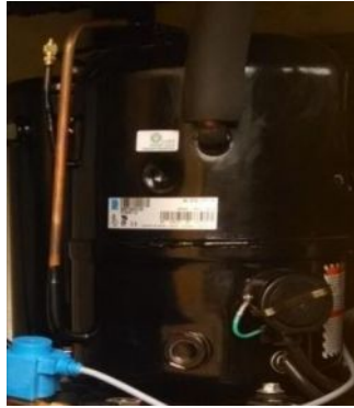
Figura 22. Compresor alternativo hermético
