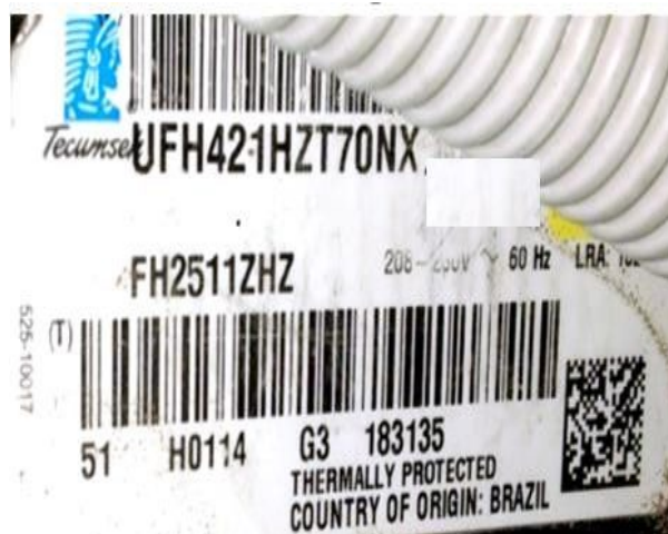
Figura 12.Datos de placa de la Unidad condensadora.
