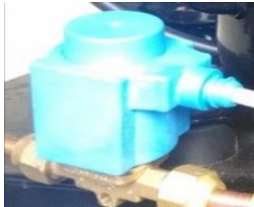
Figura 30. Válvula solenoide.
