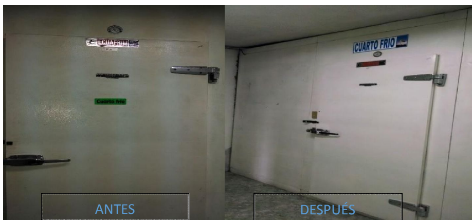
Figura 9. Condición inicial de la estructura del cuarto frío
