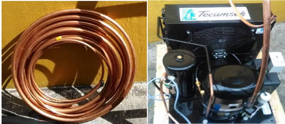
Figura 25. Tubería de cobre distribuida en la unidad condensadora
