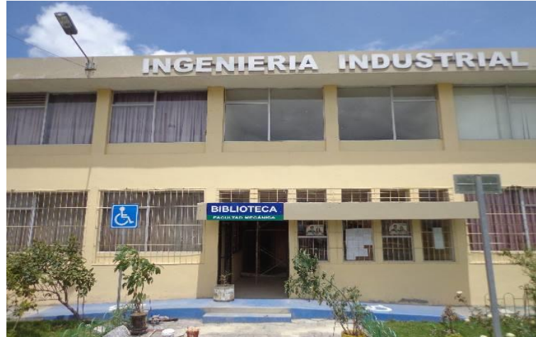
Figura 21. Edificio de Ingeniería Industrial
