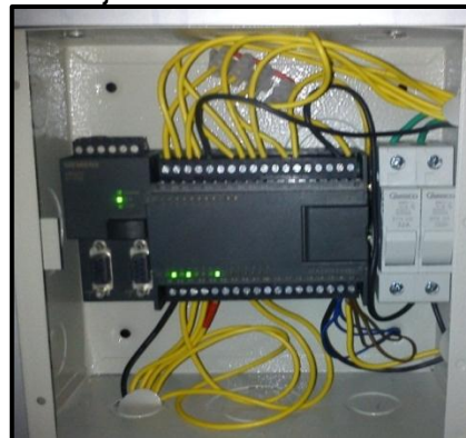
Figura 72. Montaje del PLC S7-200 en un raíl DIN
