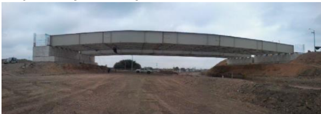
Figura 8. Vista panorámica del puente vehicular “BELLA INDIA”- Machala
