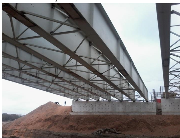
Figura 9. Arrostramiento puente vehicular “BELLA INDIA”- Machala
