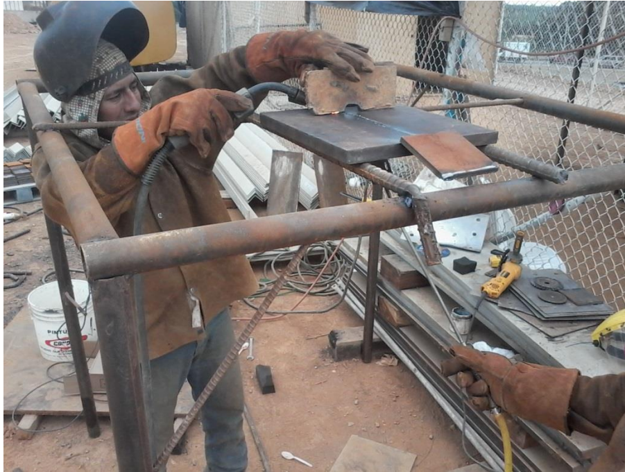
Figura 24. Placa de ensayo para espesor ilimitado-calificación para posición 4G / soldadura en campo
