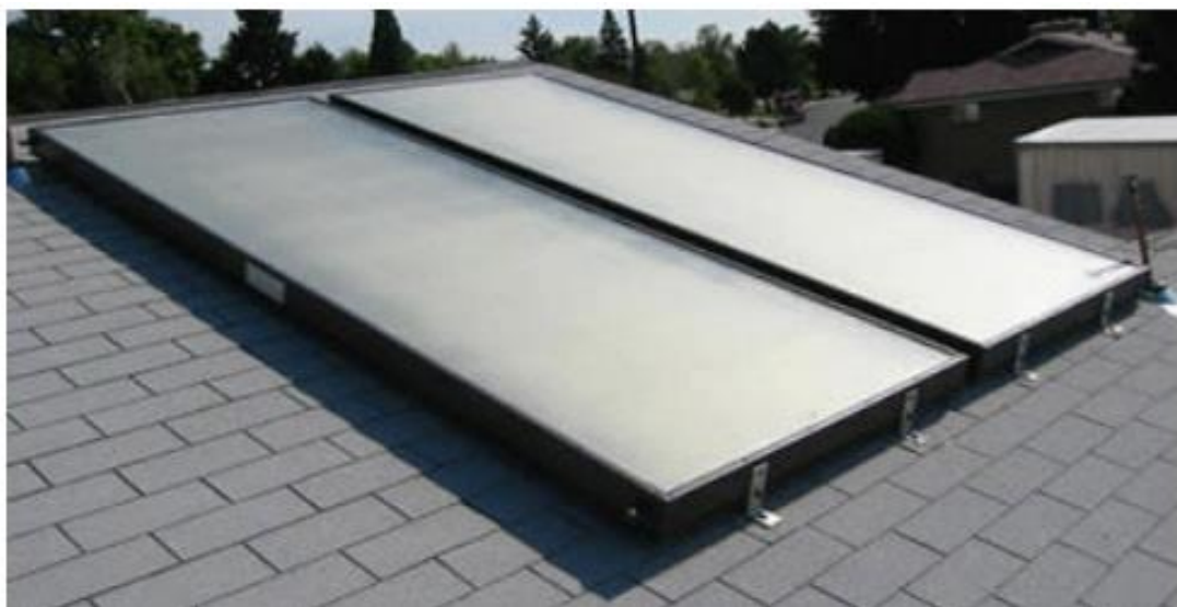
Figura 50. Foto de un colector solar de placa plana con cubierta
