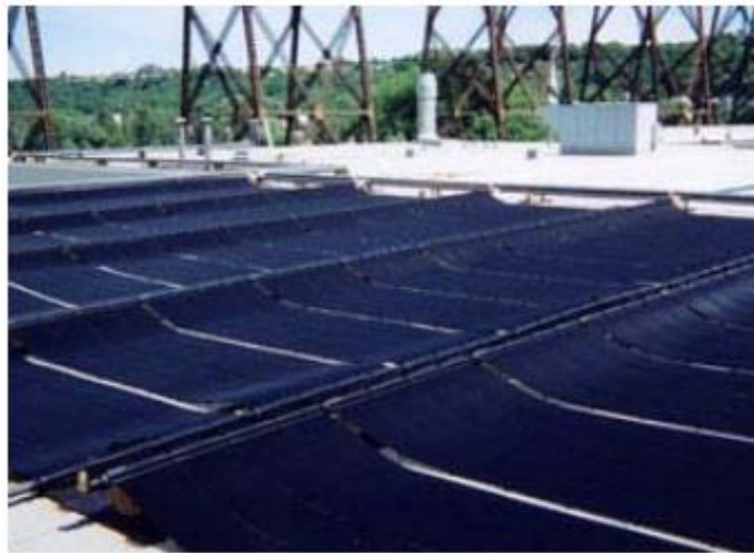
Figura 52. Foto de un colector de placa plana sin cubierta
