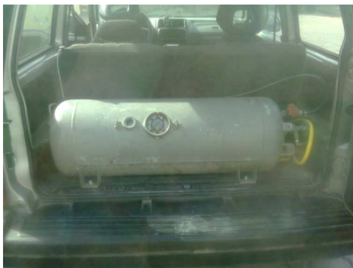
Figura 22. Instalación del depósito de G.L.P.
