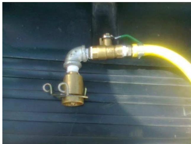
Figura 2. Válvula de llenado de G.L.P.
