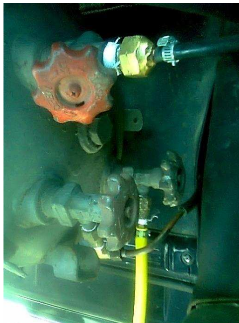
Figura 23. Instalación de las válvulas del depósito de G.L.P.
