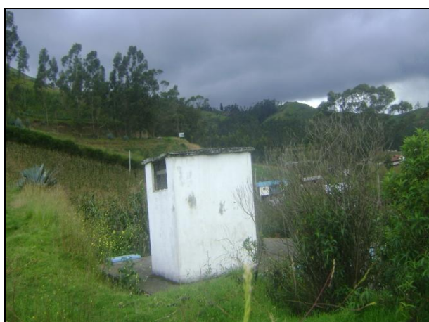
Figura 1-2. Tanque de Reserva.
