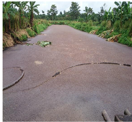
Piscina de Oxidación PEXA S.A.
