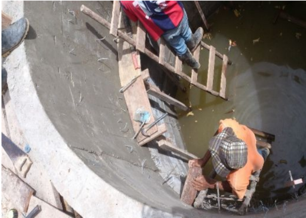
Fotografía 18 Construcción de la loza para la campana de acero
