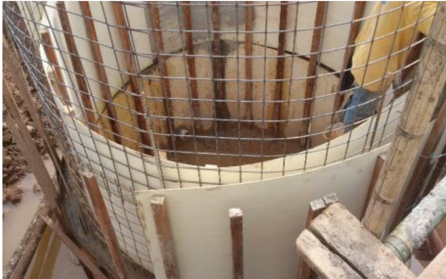
Fotografía 12 Encofrado y contrachapado
