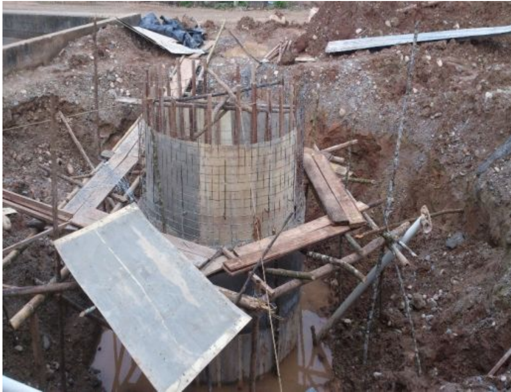
Fotografía 16 Desmontaje del encofrado y enchapado de la primera fundición
