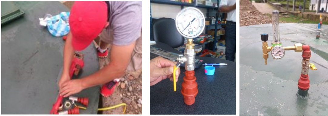
Fotografía 22 Instalación de los equipos de medición de gas
