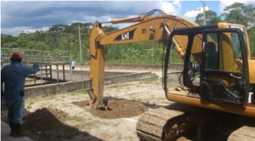
Fotografía 7 Excavación del tanque de digestión
