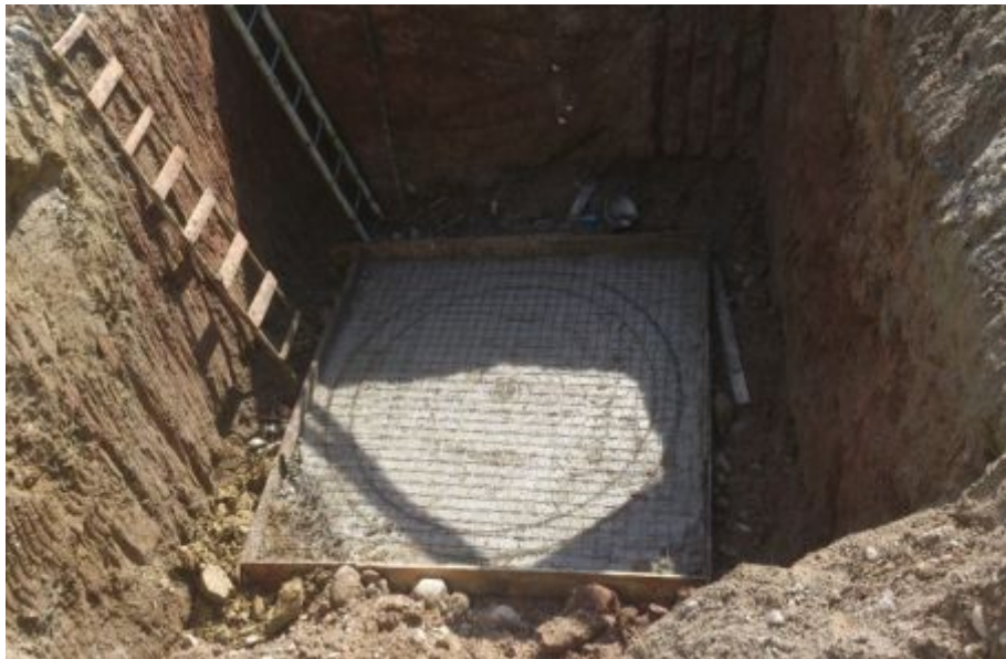
Fotografía 9 Fundición de la base del tanque de digestión
