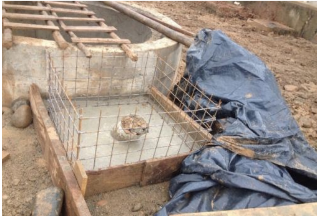
Fotografía 19 Cimentación de la caja de carga y de descarga
