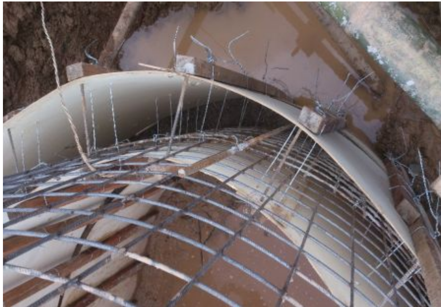
Fotografía 13 Colocación de topes y alambre galvanizado
