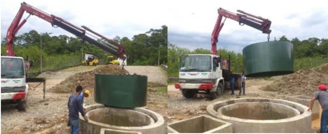
Fotografía 21 Levantamiento y ubicación de la campana
