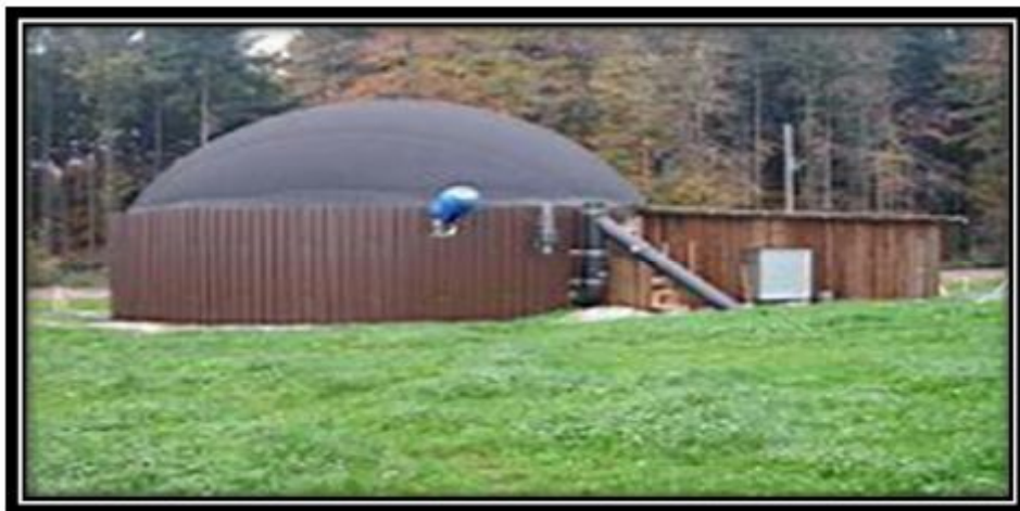
Ilustración 6-1 Biodigestor con tanque de almacenamiento tradicional y Cúpula de polietileno
