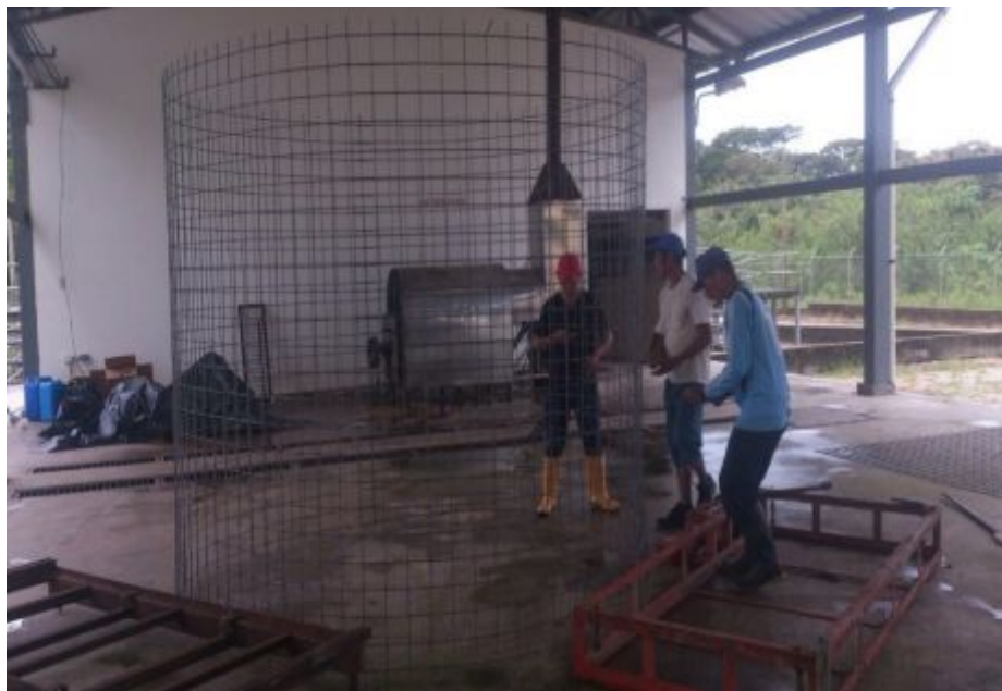
Fotografía 11 Estructura de hierro del tanque de digestión
