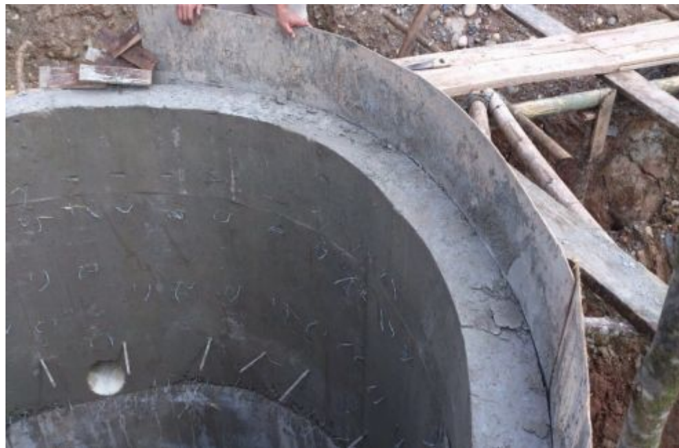
Fotografía 17 Desmontaje de la tercera fase y verificación de fugas
