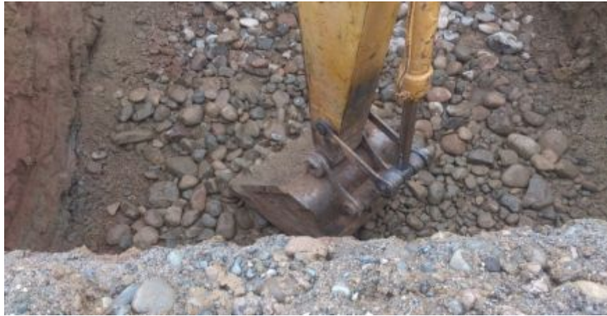
Fotografía 8 Relleno de la superficie excavada
