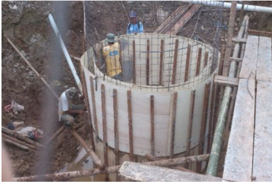
Fotografía 14 Unión de la primera y segunda fase
