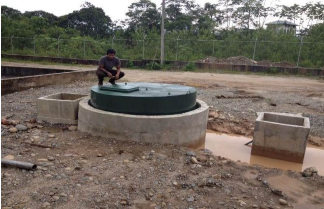
Fotografía 20 Cajas de carga y descarga vista frontal
