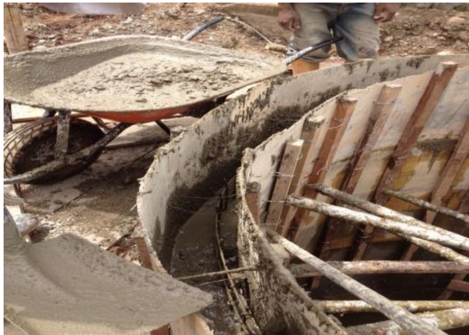
Fotografía 15 Fundición de la primera y segunda fase
