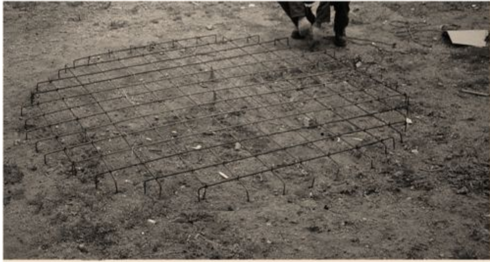
Fotografía 10 Fabricación de la malla de 8 mm
