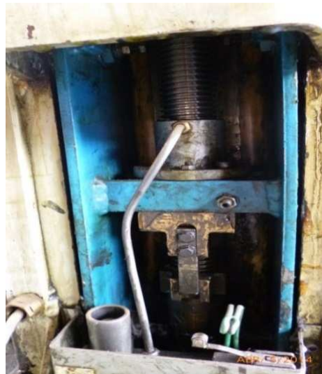
Figura 52. Estado de sistema de transmisión
