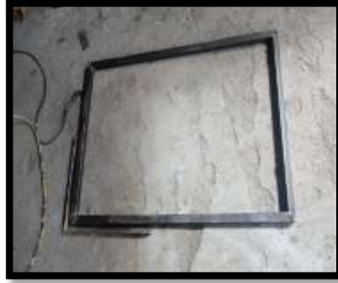
Figura 47. Armado de la estructura
