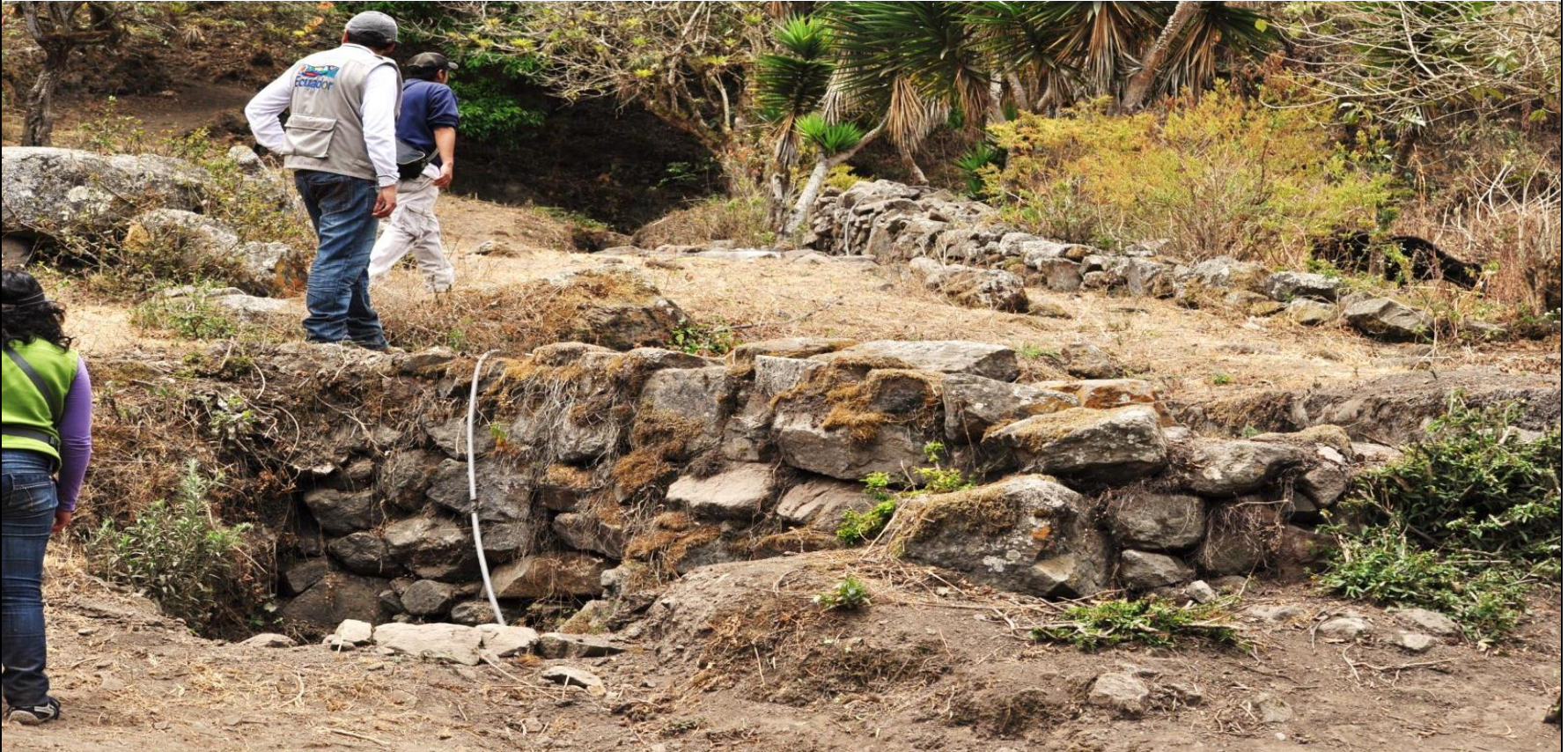
Fotografía #17. Vista lateral del tanque de agua
