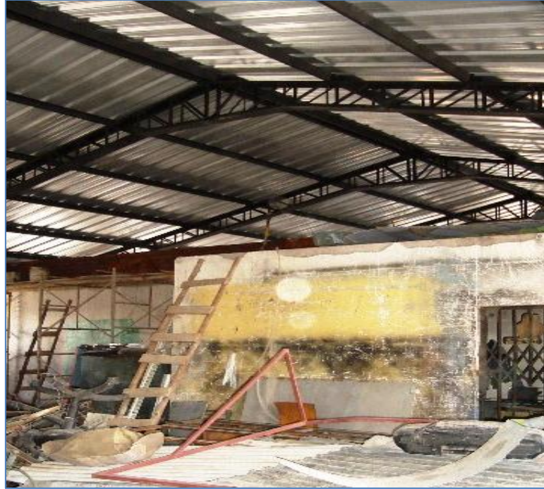
Figura 5.4: Cambio de cubierta en el área de mecánica industrial.
