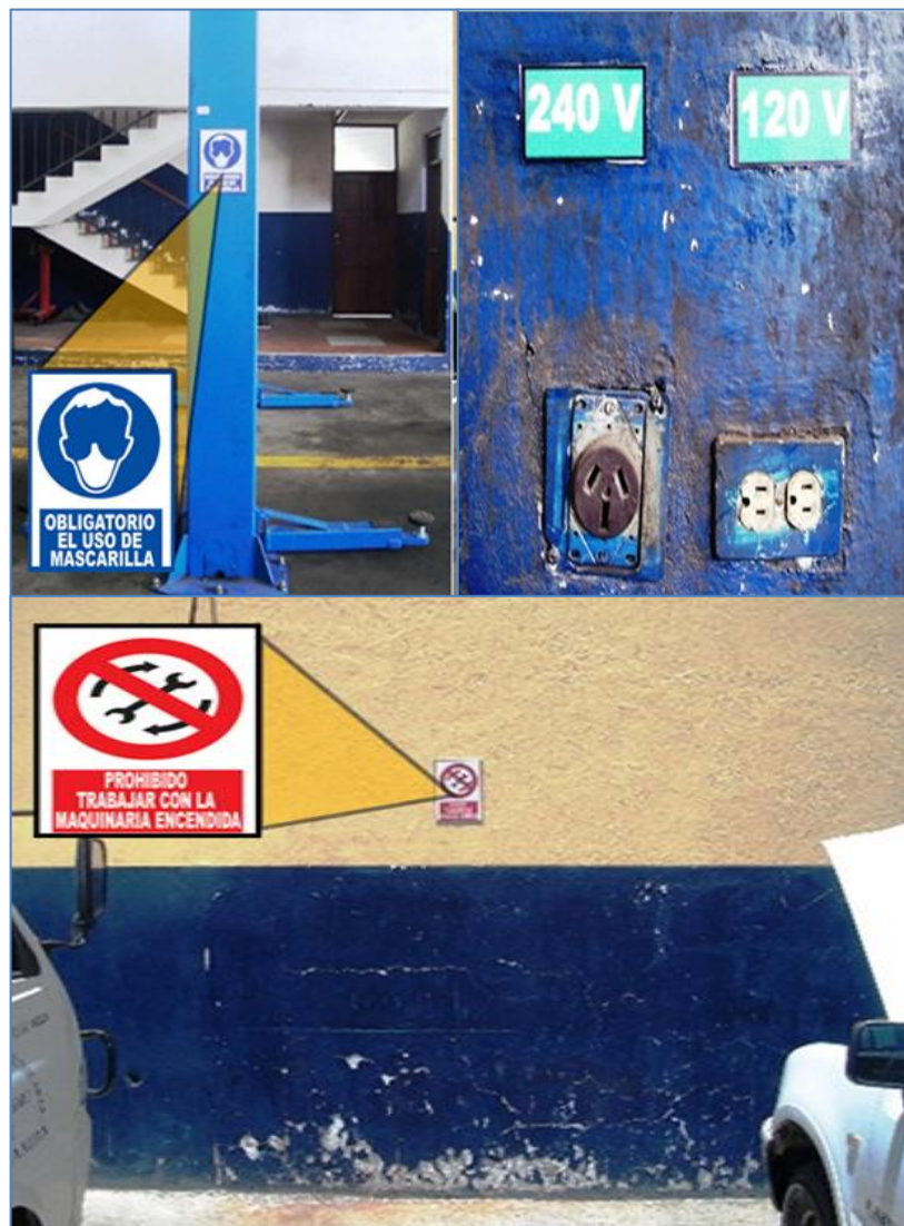
Figura 4.19. Ubicación de señales de seguridad en el área de Mecánica Automotriz.
