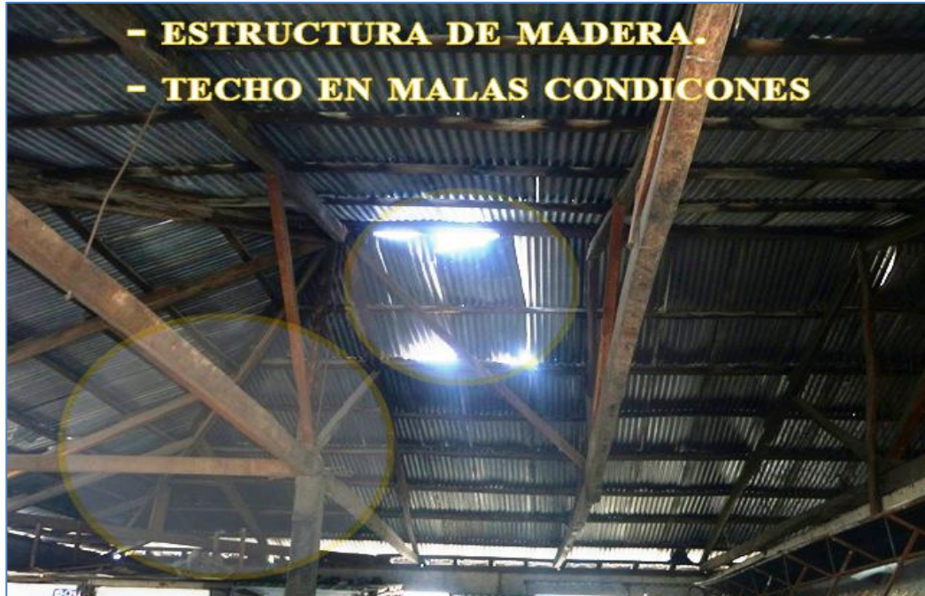
Figura 5.1: Cubierta del área de mecánica industrial.
