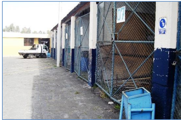
Figura 4.16. Ubicación de las identificaciones de bodegas y señales de obligación.
