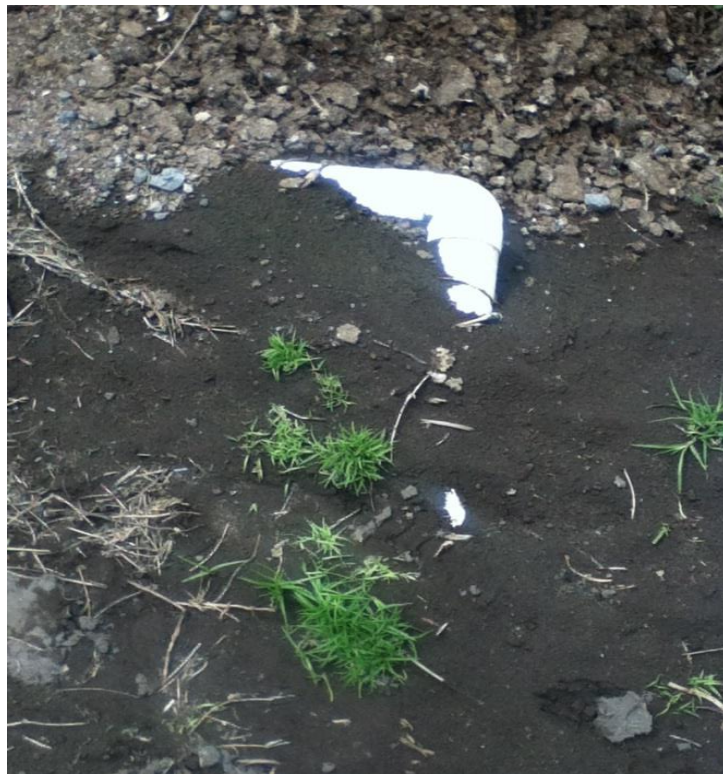
Fotografía 7. Drenaje y acumulación de las aguas residuales.
