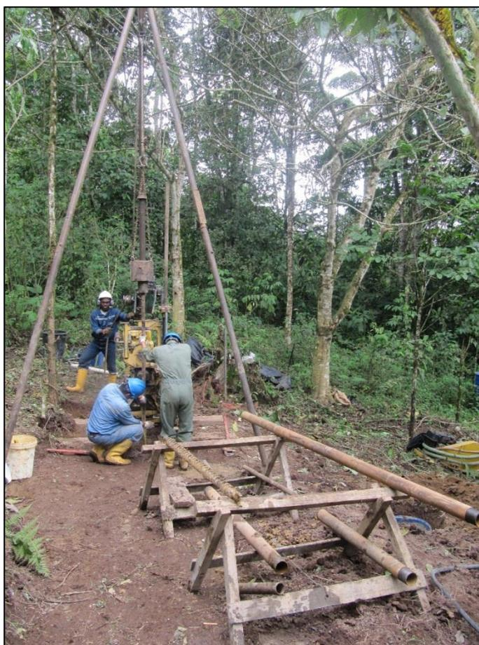
**Foto 5:** Ensayo de Test de Penetración Estándar
