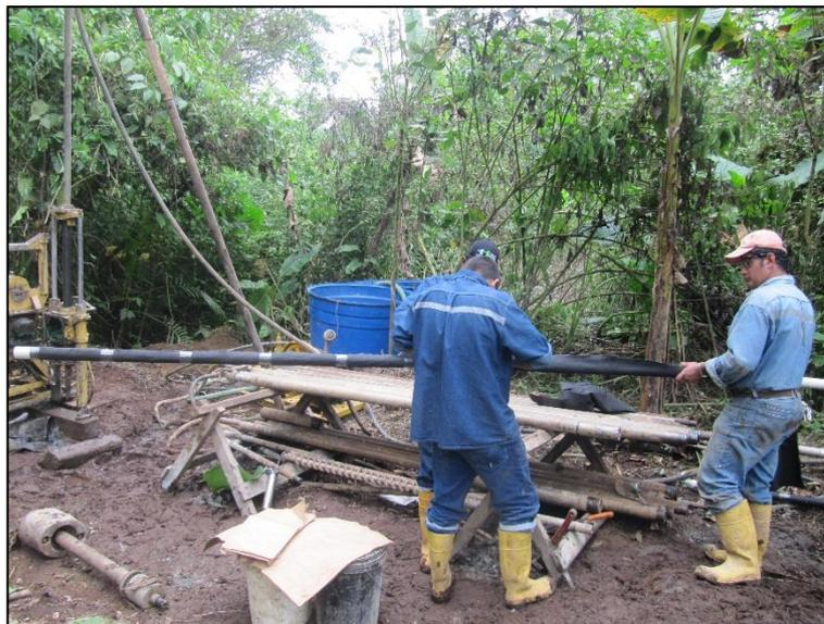
**Foto 6:** Colocación del piezómetro
