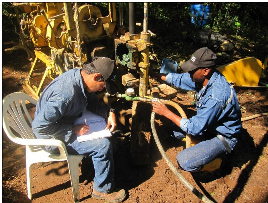
**Foto 8:** Medición del Caudal de Agua Absorbido
