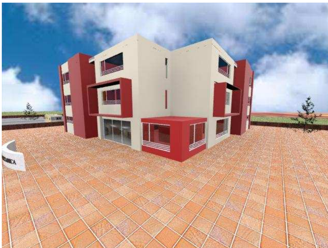
Figura 9. Edificio de laboratorios de la Facultad de Mecánica
