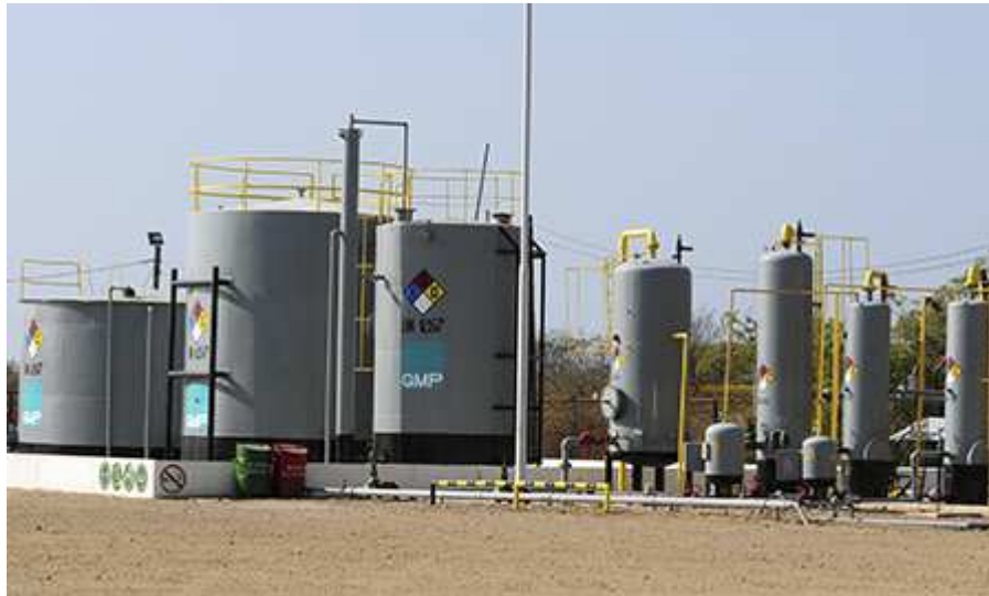
Figura 1. Almacenamiento de petróleo
