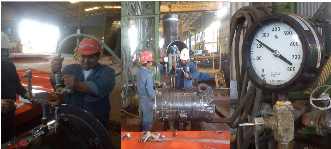
Figura 65 Prueba hidrostática
