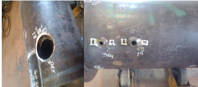
Figura 51 Instalación de couplings
