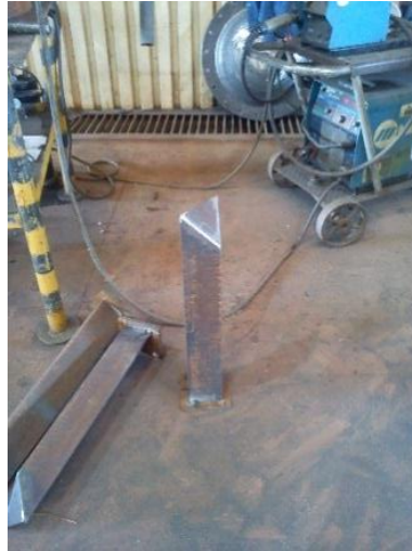
Figura 55 Soportes del caldero (Legs)
