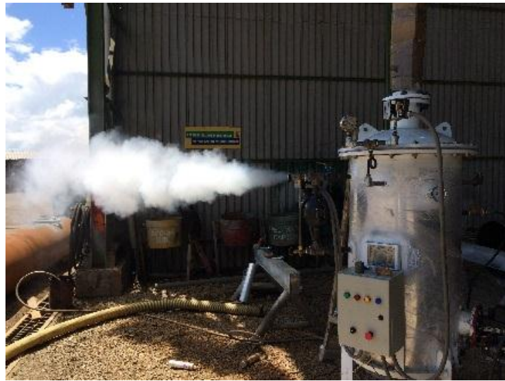
Figura 69 Instalación de los equipos
