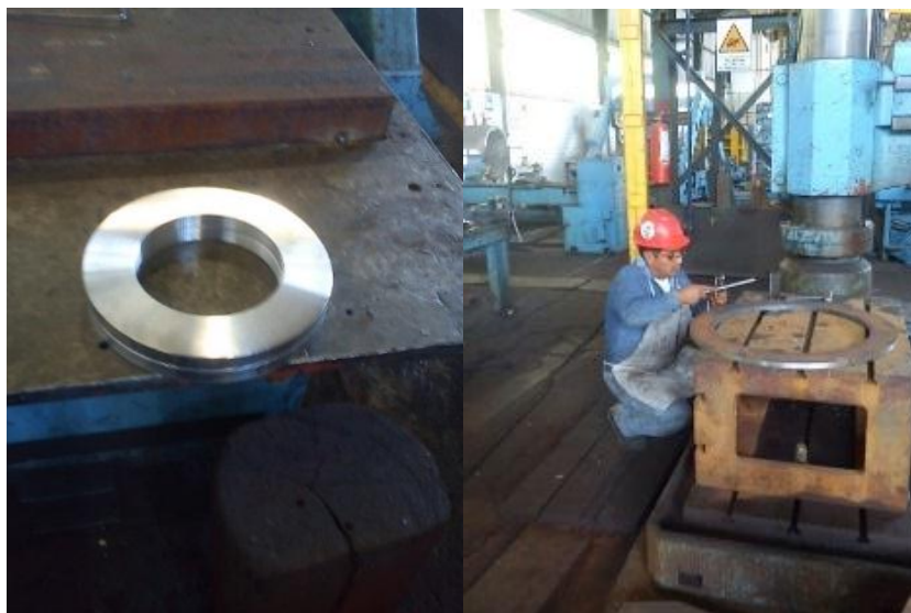
Figura 54 Perforación de las bridas
