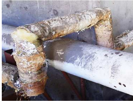
Figura 43. Colocación de los aislamientos
