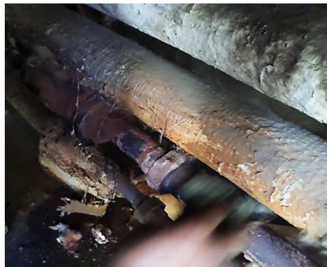
Figura 20. Limpieza de la superficie
