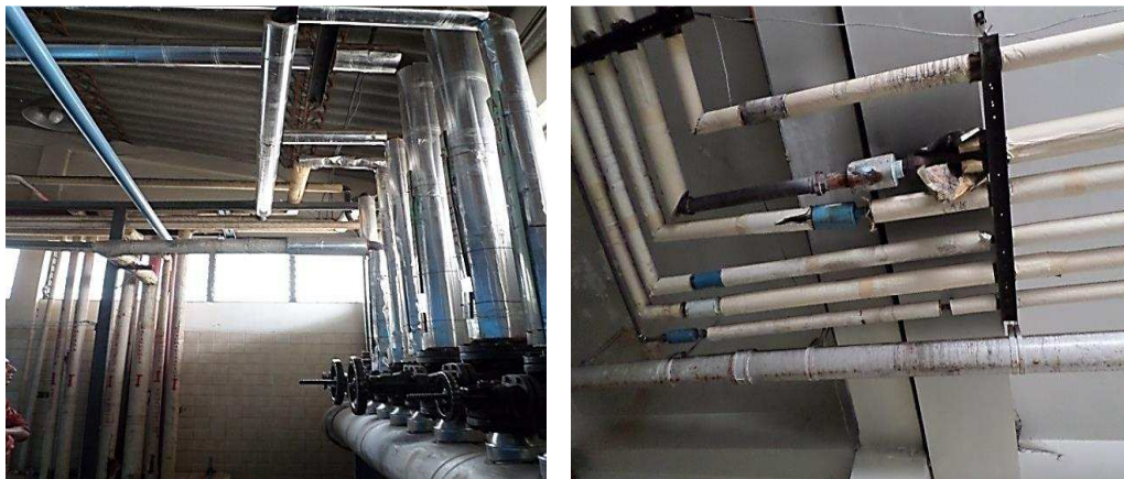
Figura 39. Seguimiento de las tuberías de vapor
