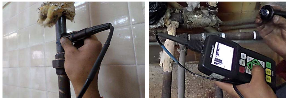
Figura 51. Toma de medidas de espesores
