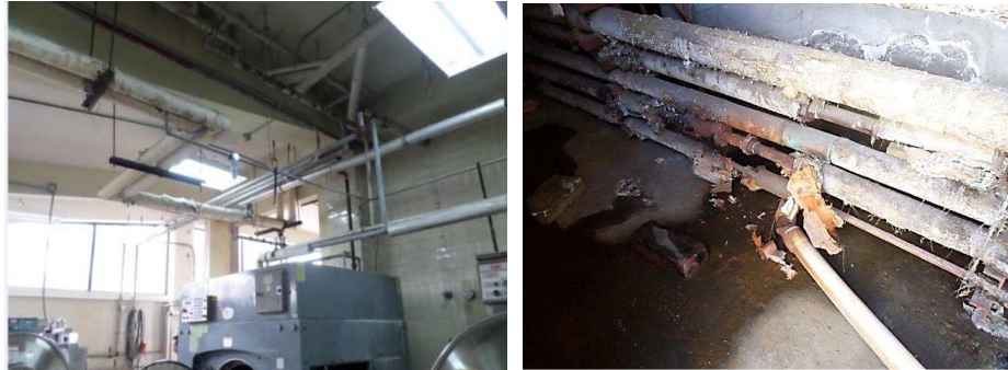
Figura 50. Inspección de las líneas de vapor
